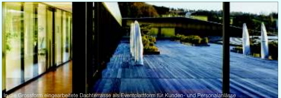
In die Grossform eingearbeitete Dachterrasse als Eventplattform für Kunden- und Personalanlässe
